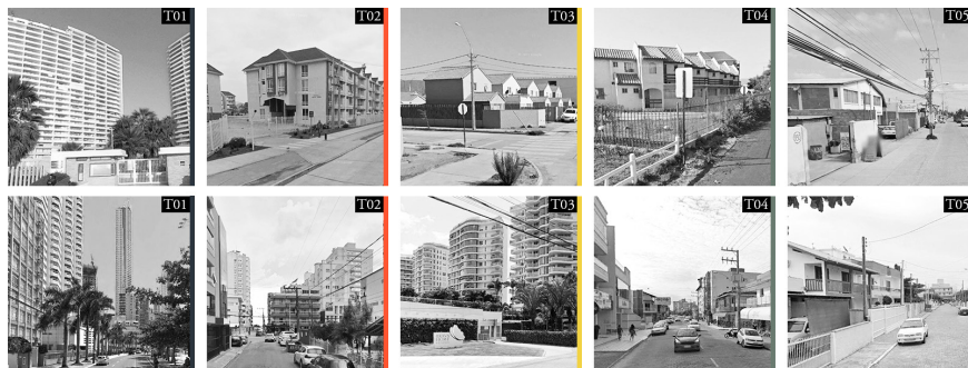
FIGURA 9 | Principales tipologías edilicias de las zonas turísticas en las conurbaciones La Serena-Coquimbo (arriba) e Itajaí-Balneário Camboriú (abajo). Los colores en las imágenes corresponden a los colores indicativos de las tipologías en las Figuras 6 y 7 [rojo, T02; amarillo, T03]
