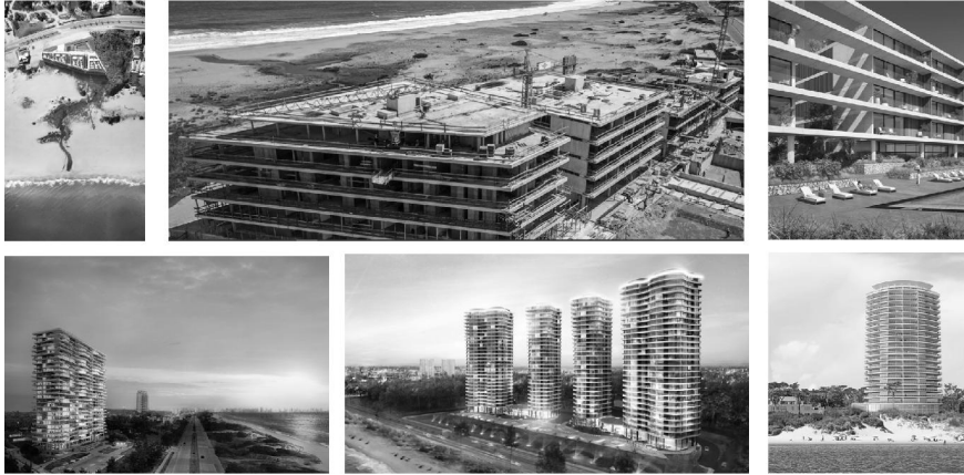
FIGURA 5 | Arriba: tipología condominio The Colette. Abajo: tipología edificio en primera línea frente al mar Venetian Tower, Fendi Chateau y Paramount
