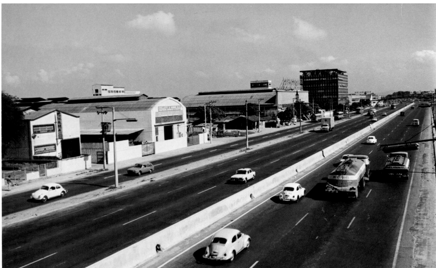
FIGURA 2 | Avenida Brasil, sentido zona oeste, em 1968, altura de Ramos
