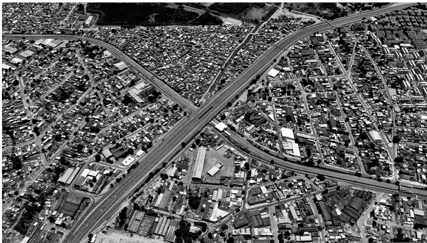
FIGURA 8 | Viaduto da Avenida Brasil sobre o ramal ferroviário de Saracuruna (antiga Estrada de Ferro Leopoldina)
