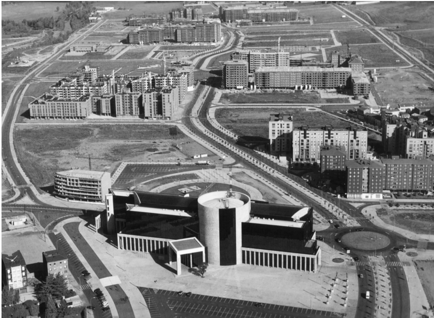
FIGURA 4 | Polígono Eras de Renueva (León), en construcción
